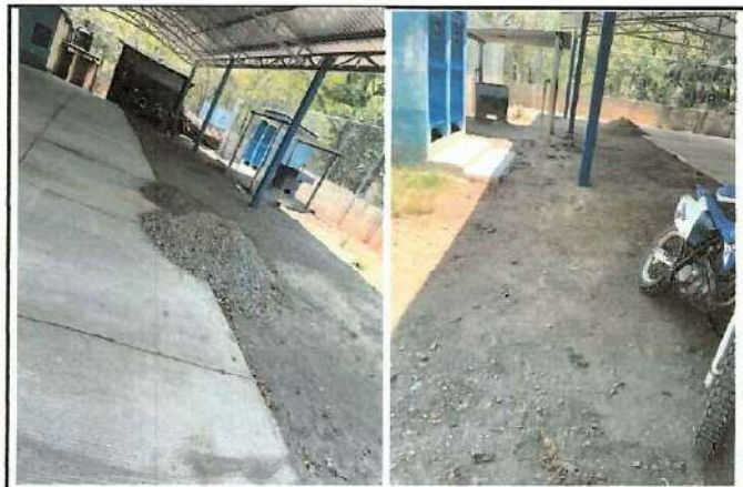
Foto 4: Bloque 4 Losa de patio
