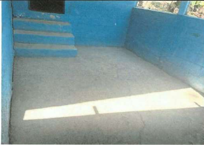
Foto 1: Bloque 3 Módulo de piso antideslizante de corredor del aula de preprimaria.
